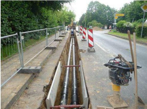
Das Wärmenetz wird in einem ca. 1 Meter breiten Graben verlegt.
