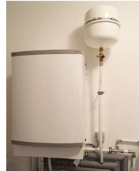
Schnittstelle zwischen Nahwärmenetz und Heizungsanlage im Haus ist die Wärmeübergabestation.
